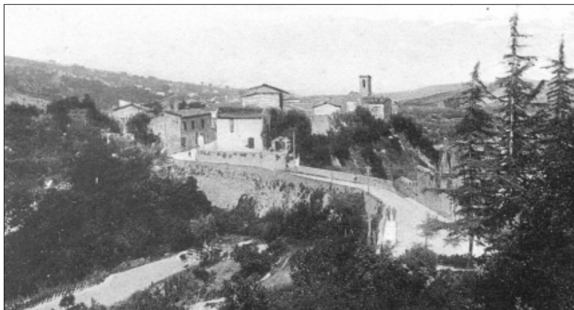
Capocastello (1) - la foto mostra la viabilità originaria verso la "Villa" (Campli). Si nota, a destra, il Convento di S. Onofrio ancora integro.
