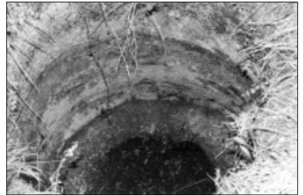
N’vire , neviera sulla Montagna di Campli realizzata dai battagliesi (boscaioli e carbonari) scavando profonde buche nella roccia.
