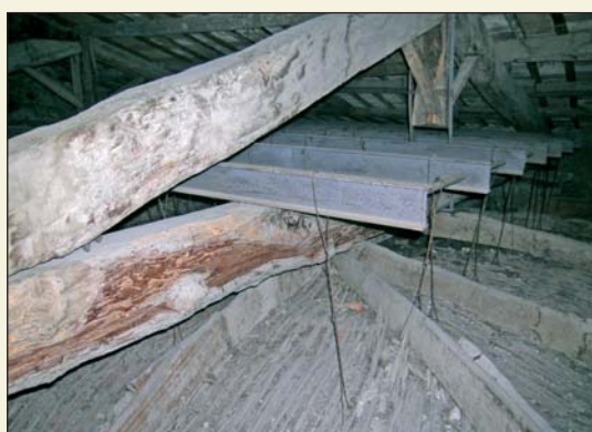
Sistema costruttivo della volta del grande salone di Palazzo Rozzi. Recentemente è stato restaurato insieme a tutte le coperture della struttura
