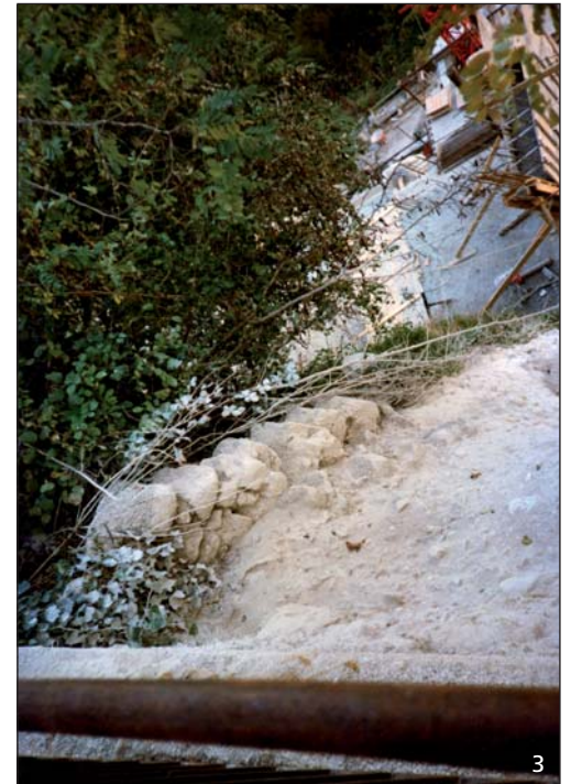
1-2-3 Foto di Cantiere durante la realizzazione del muraglione sulla scarpata del Siccagno, prospiciente la chiesa di S. Francesco. Si notano le fondamenta "arrotondate" del torrione. 4 Cartina prospettica "De Silva" fine Seicento. 5 Particolare di Affresco nell'ex Badia di S. Onofrio in Campli. L'affresco può essere riferito ai primi anni del Cinquecento
